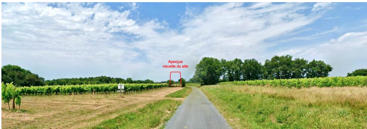
Première perception du site, à 150 mètres en venant de l'Est sur la VC n°7 : un impact visuel encore plus limité
