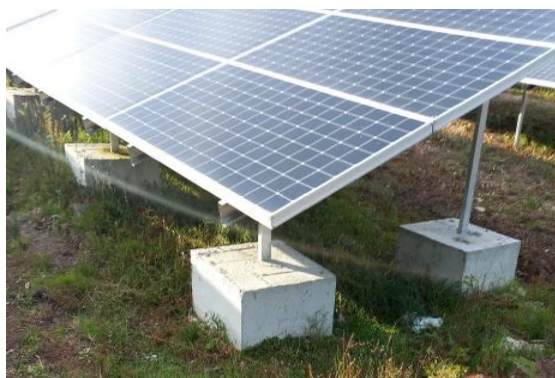
Structure des panneaux photovoltaïques
