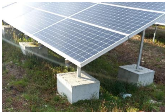
Structure des panneaux photovoltaïques
