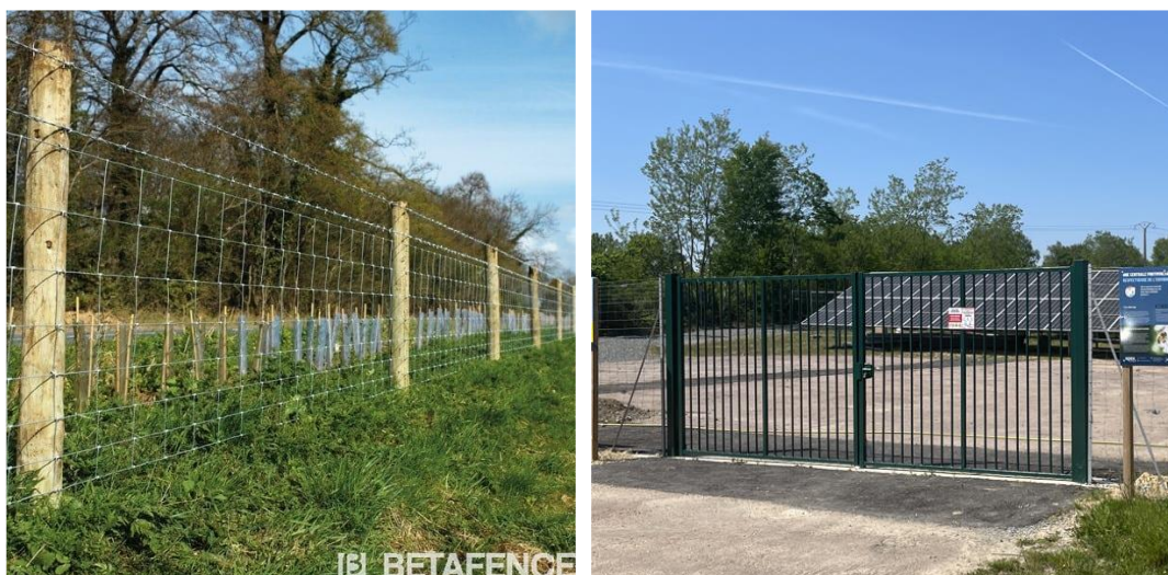
Photographies de référence de la clôture et du portail du futur projet
